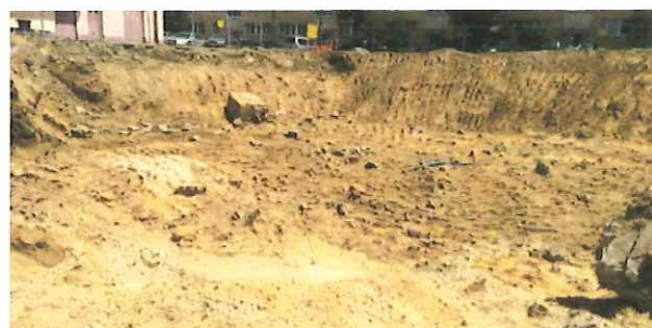
Dozór geologiczny i potwierdzenie występowania nośnego podłoża.
