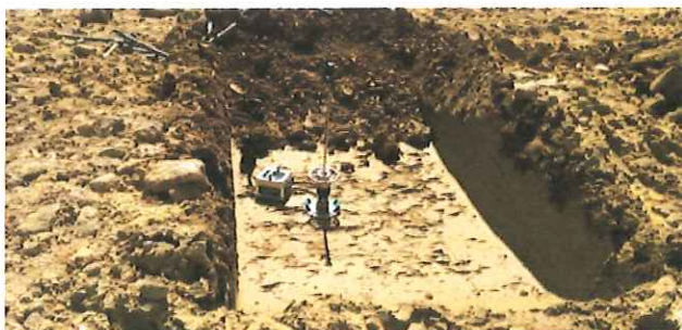
Dozór geologiczny i potwierdzenie występowania nośnego podłoża. Badania płytą dynamiczną
