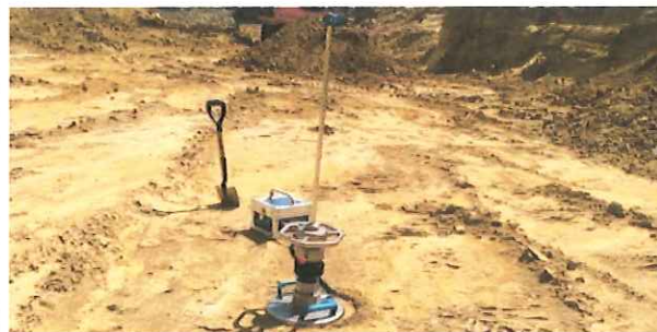
Dozór geologiczny i potwierdzenie występowania nośnego podłoża. Wykopy pod fundament w osi A 3
